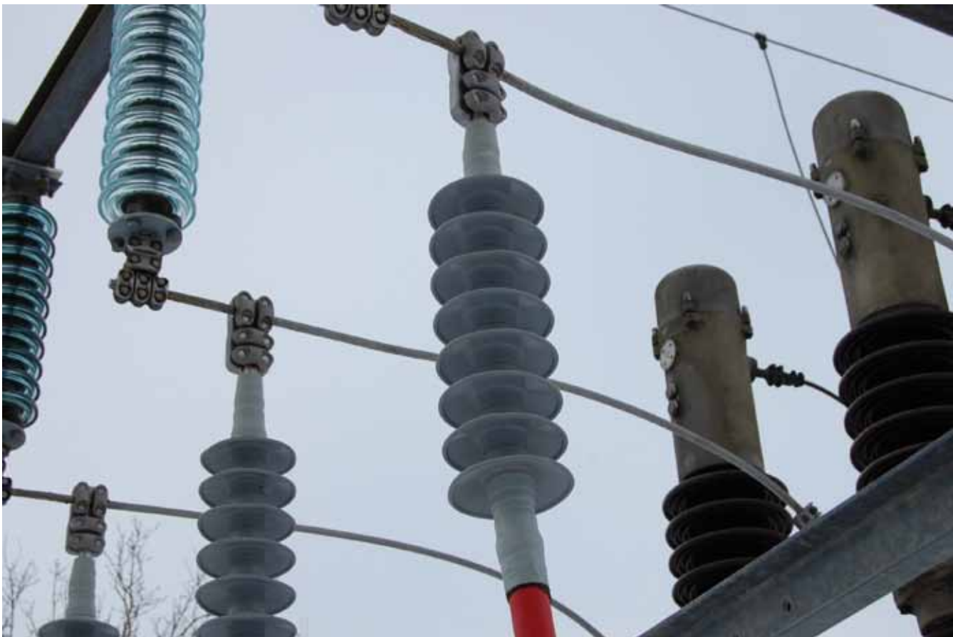
72,5 kV 3M Koldkrymp-endeafslutning som bliver demonstreret på El og Teknik 2010
